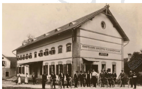
Zadružna zgradba leta 1911
